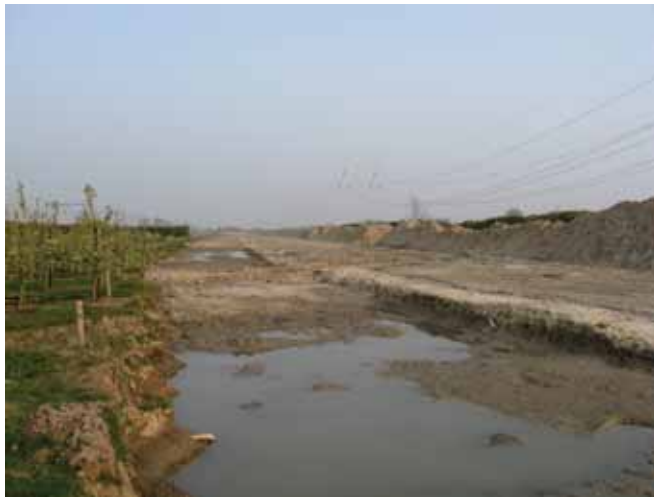
Figuur 3.3. Grondwerken in de Karelpolder, april 2008 (JK).
